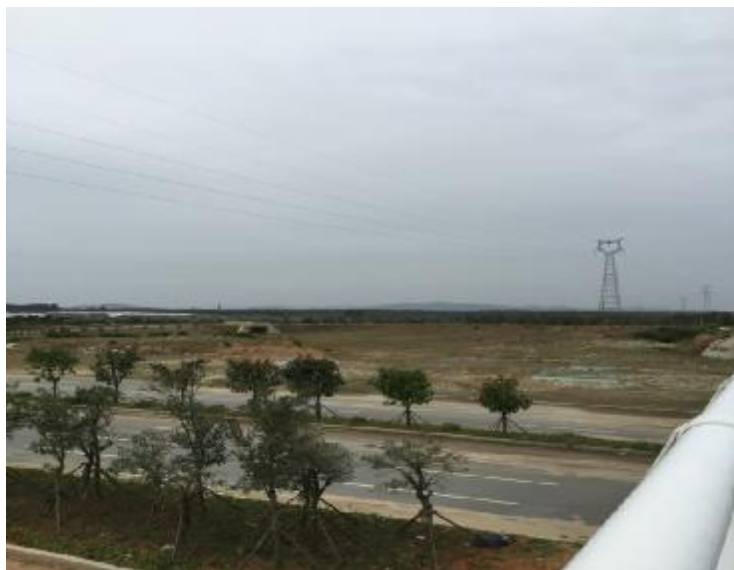
S3#施工场地
