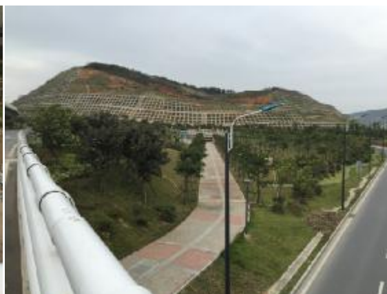
S2#施工场地
